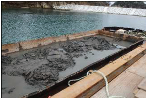
浚渫土砂運搬
