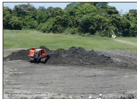
農地運搬・敷き均し
