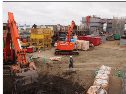
施工ヤード全景
