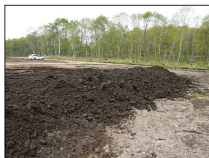
改良土仮置き状況
