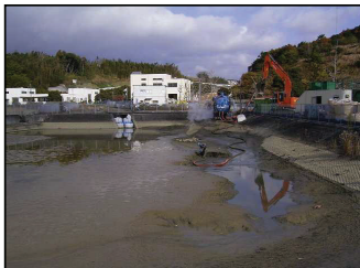
調整池堆積土砂浚渫状況
