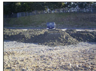
盛土撒き出し状況
