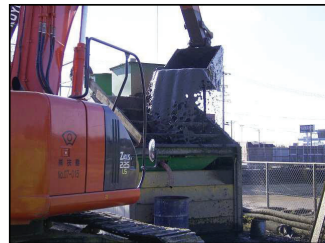
一次処理後泥土投入状況
