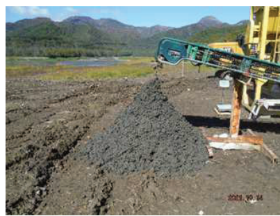
改良土排出状況
