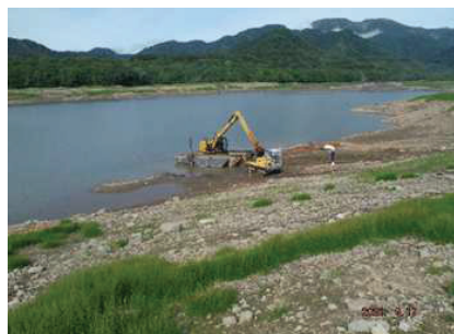
底泥土採取状況
