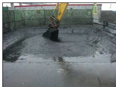
浚渫土砂調泥状況
