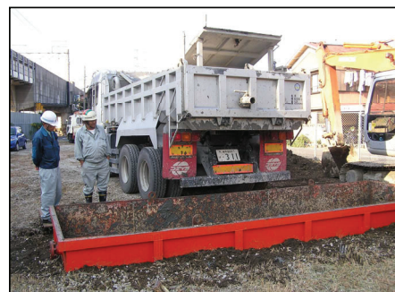
掘削土砂搬入状況
