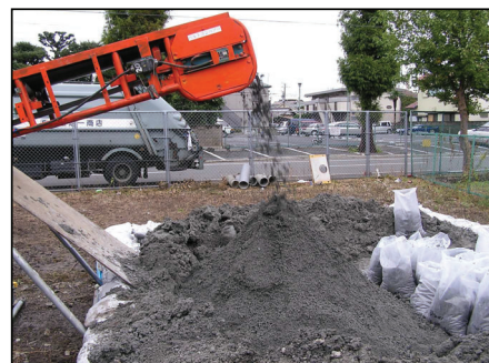
処理土排出状況
