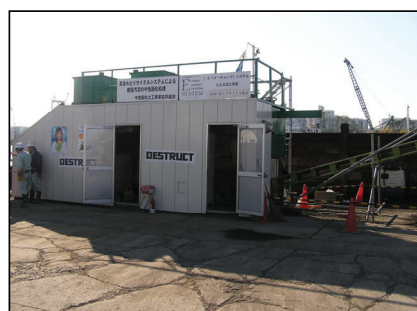
泥土再資源化装置（25m 3 ユニット）
