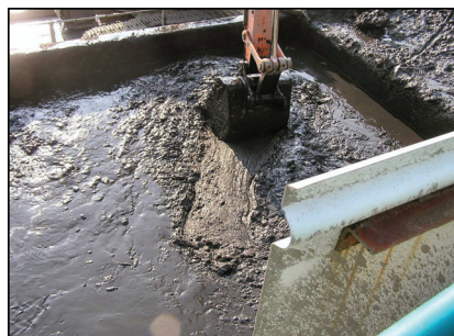
浚渫土砂貯泥状況
