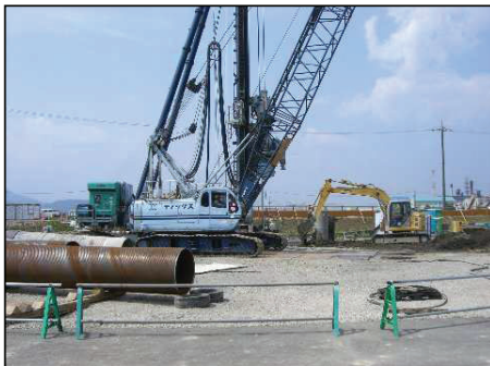
鋼管ソイルセメント杭施工状況
