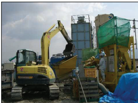
鋼管ソイルセメント杭施工状況
