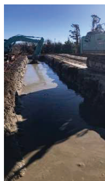
地盤改良排泥貯泥
