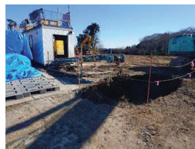
処理土搬出状況
