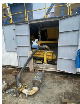
40m 3 機-送泥状況
