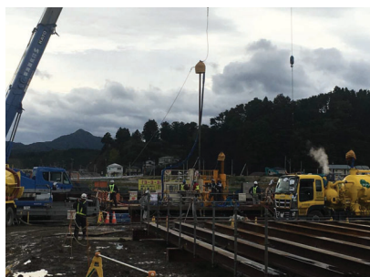
地盤改良工事
