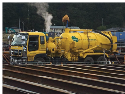
バキューム車による泥土運搬
