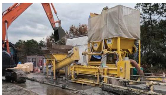
泥土処理状況
