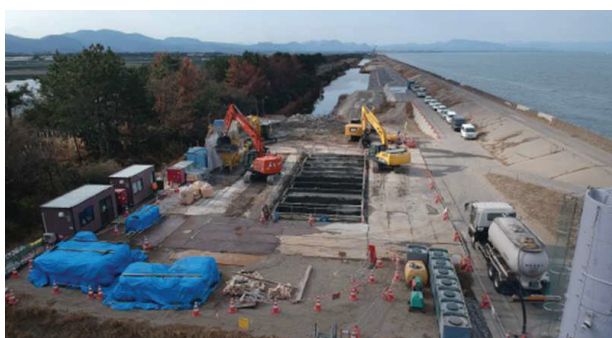
40m 3 機-排泥-貯泥調泥処理状況
