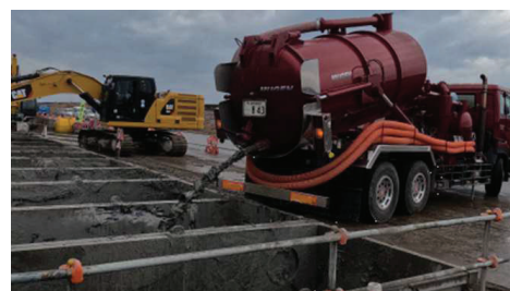
泥土搬入（バキューム車）
