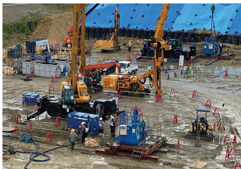
高圧噴射攪拌工事
