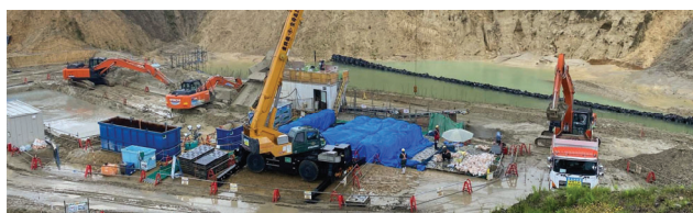
40m 3 機-排泥-貯泥調泥処理状況
