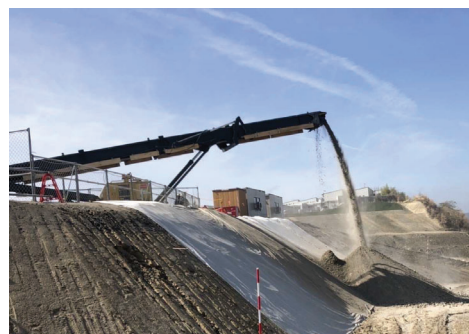
処理土搬出状況
