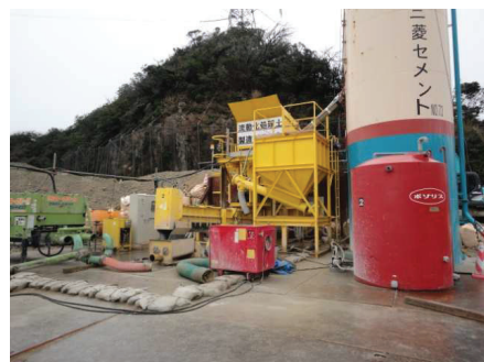
流動化処理プラント
