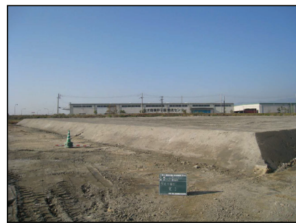
処理土盛立状況
