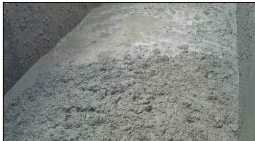
泥土圧シールド掘削排泥状況
