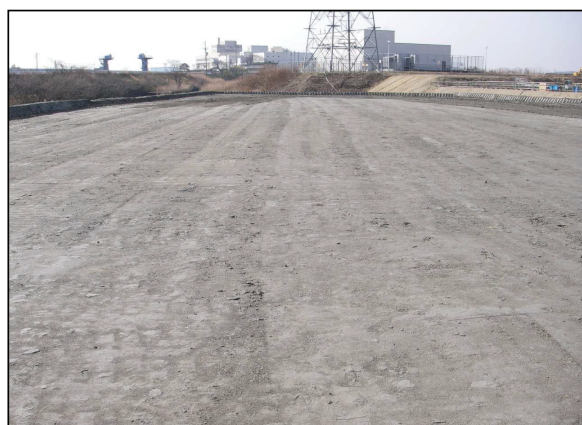
盛土転圧完了
