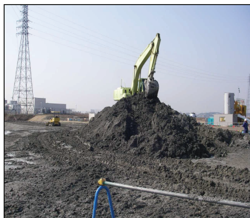
処理土敷均し状況
