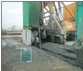
連続地中壁施工状況
