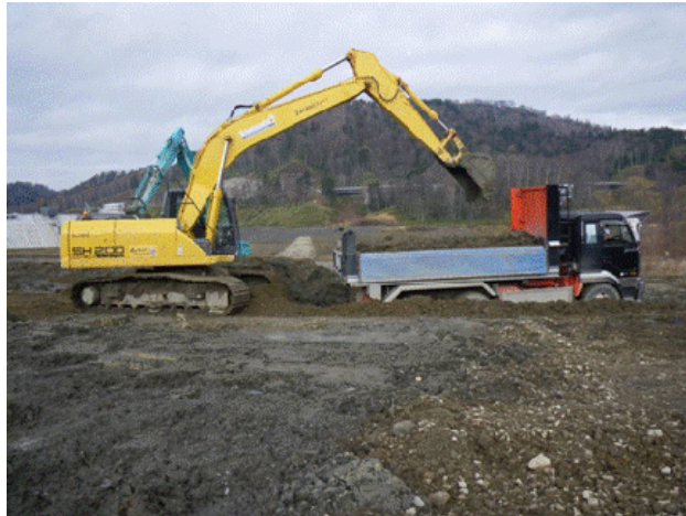
写真. 改質材積み込み状況
