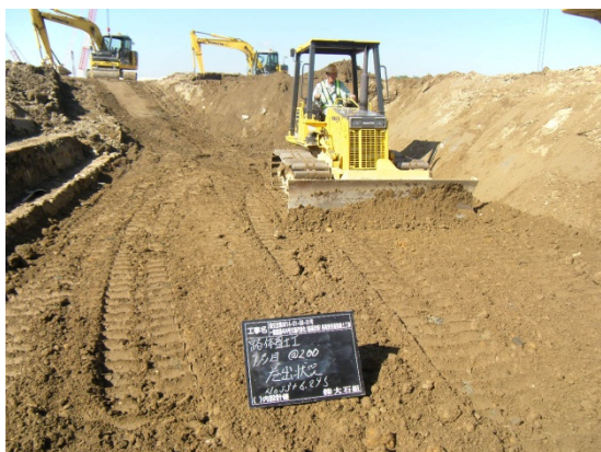
写真. 巻出し状況
