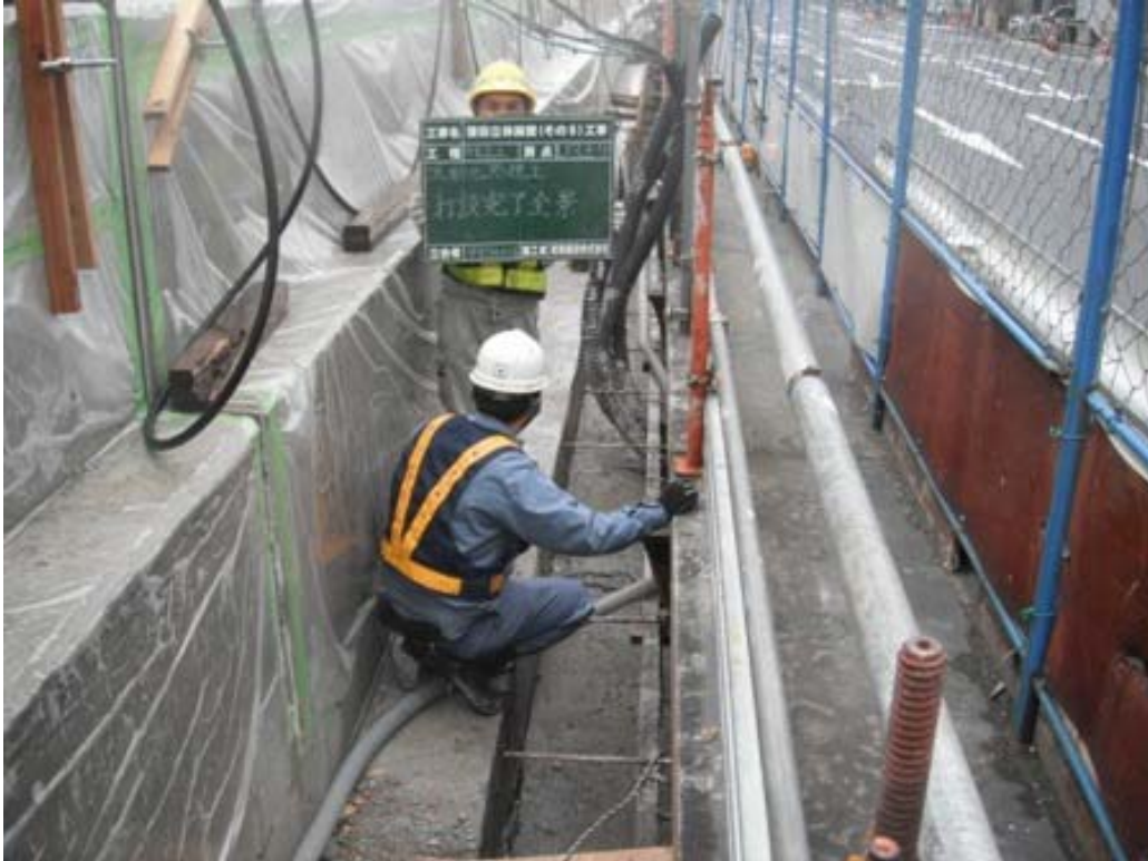
写真. 流動化処理土打設完了
