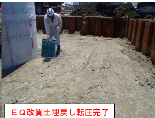
EQ改質土埋戻しコーン指数測定状況
