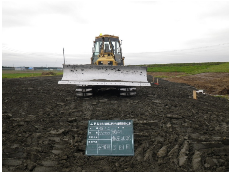
写真. 転圧状況
