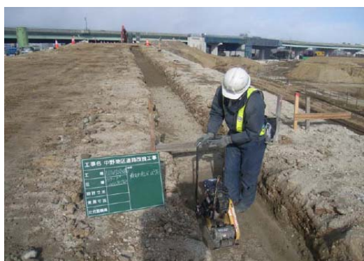
写真. 敷砂転圧状況
