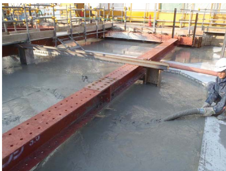
写真. 流動化処理土搬入状況
