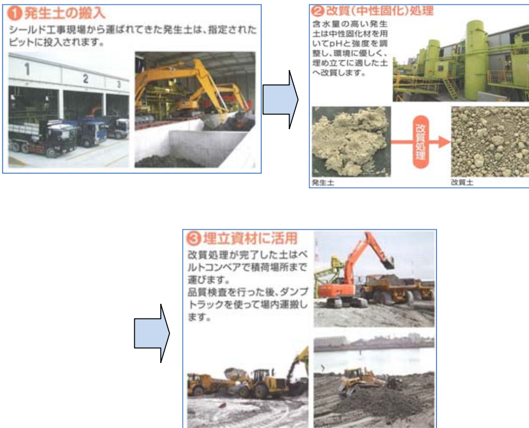
図. 建設汚泥処理の流れ
