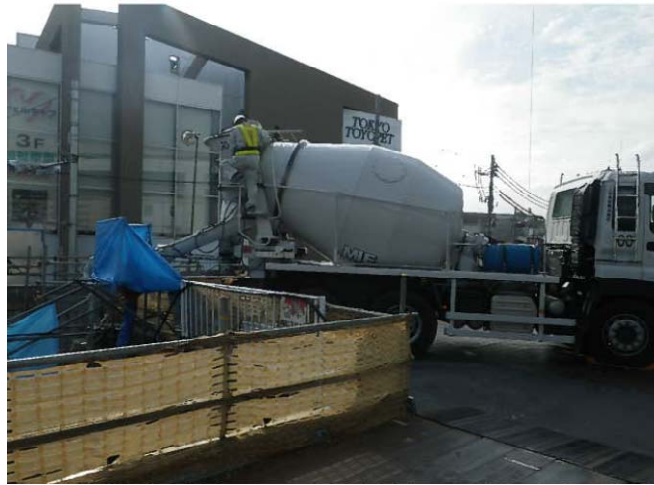
写真. 流動化処理土のシュートによる打設状況
