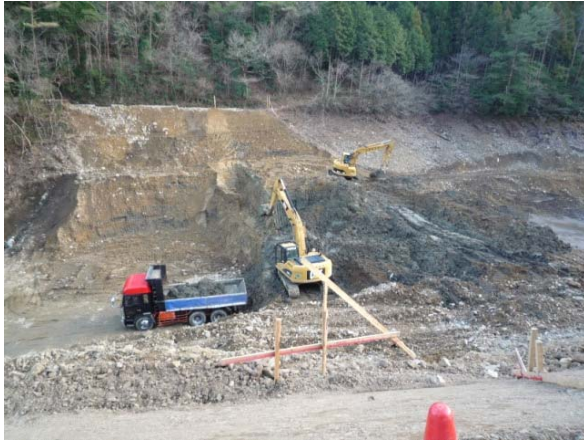
③改良後（下流のピット内で攪拌し、直置き）
