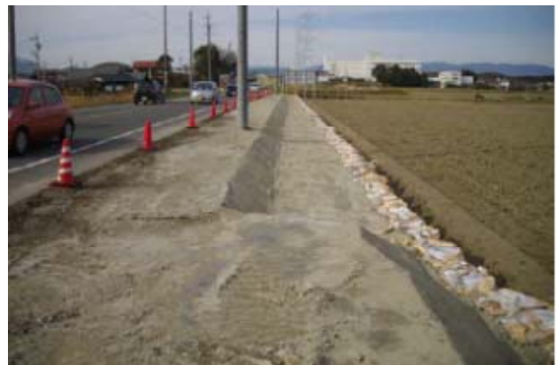
写真. 仮設道路の盛土完了
