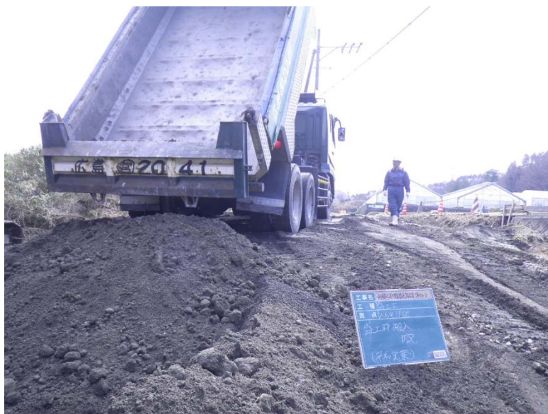
写真. 建設汚泥処理土搬入状況
