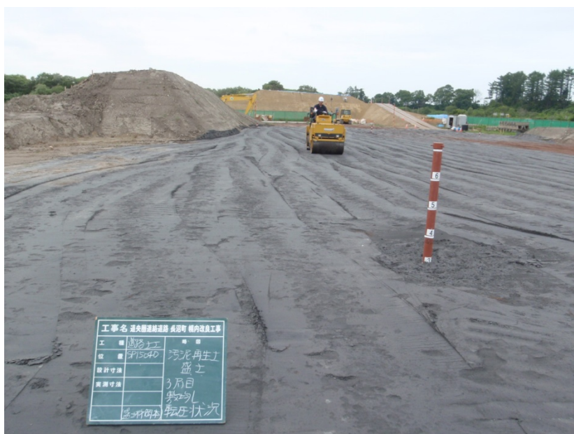
写真. 転圧状況
