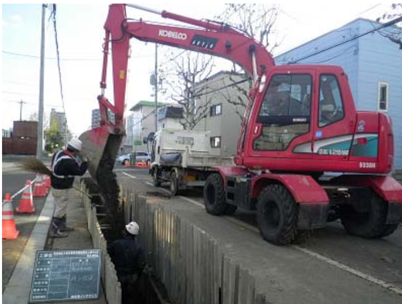
写真. 建設汚泥処理土搬入状況
