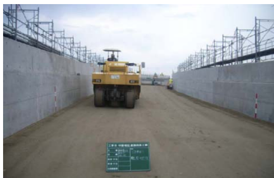
写真. 路床転圧状況
