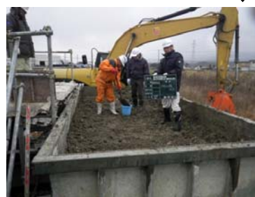
改良材採取状況
