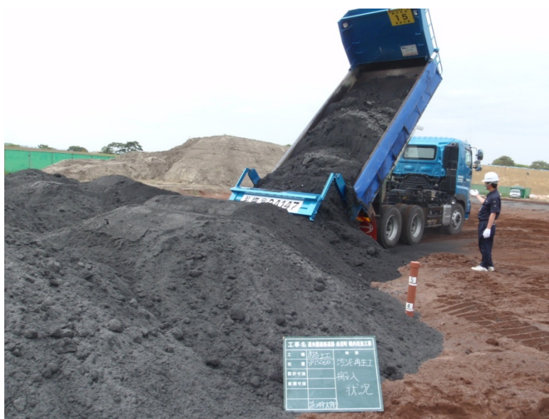
写真. 建設汚泥処理土搬入状況
