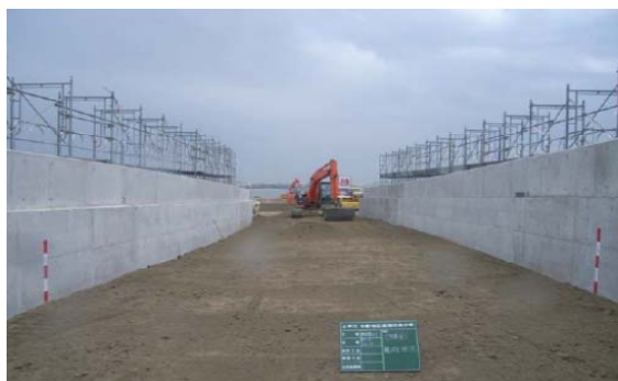
写真. 路床敷均し状況
