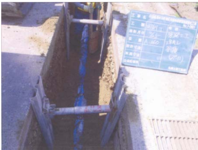
写真. 人力埋戻し状況
