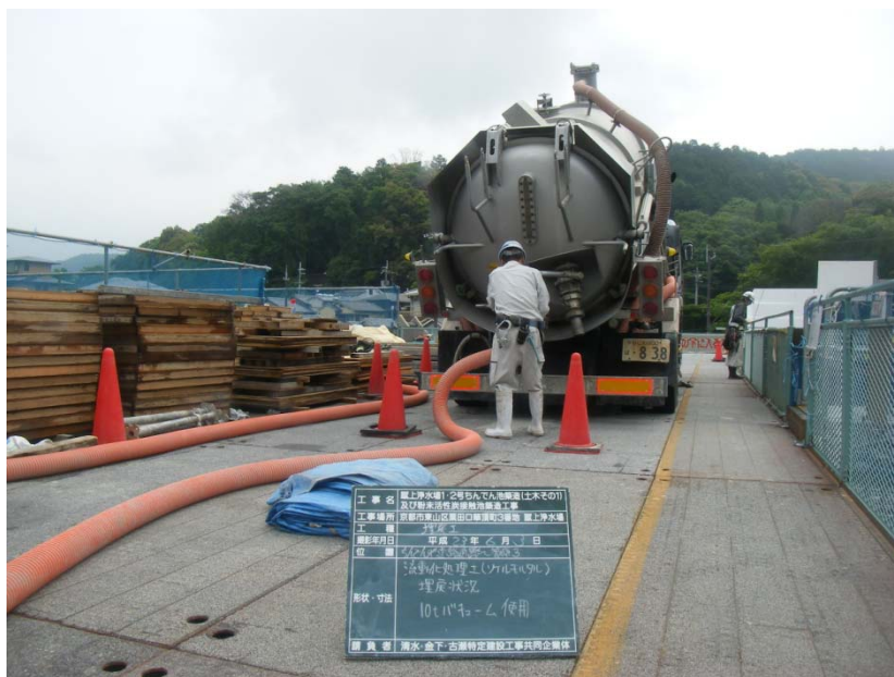
写真. 流動化処理土搬入
