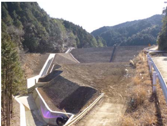
⑤施工完了後（堤体外下流盛土箇所）
