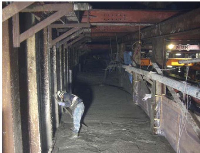
写真. 流動化処理土打設状況
