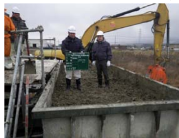
改良完了確認
