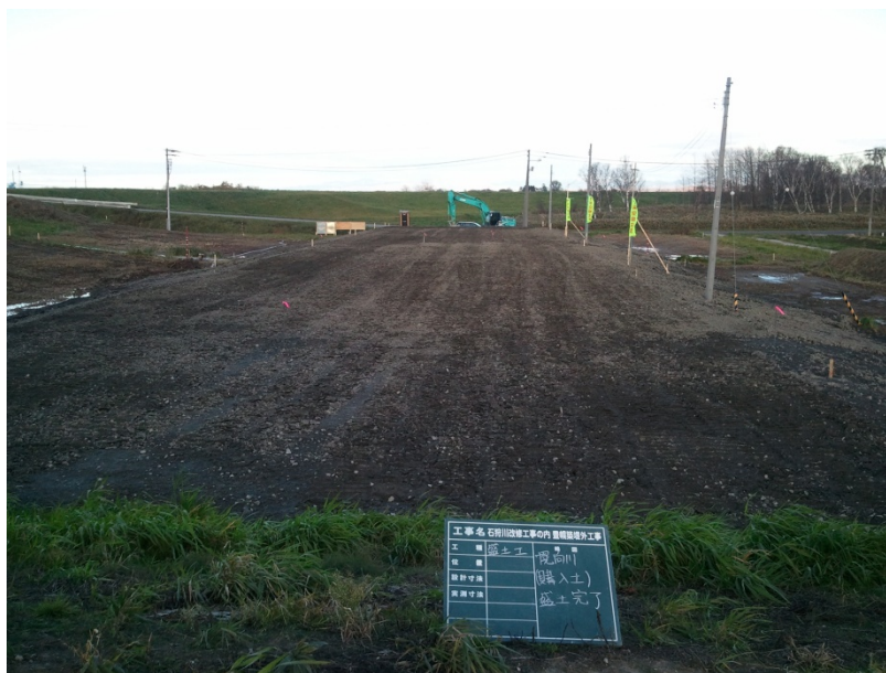
写真. 盛土完了
