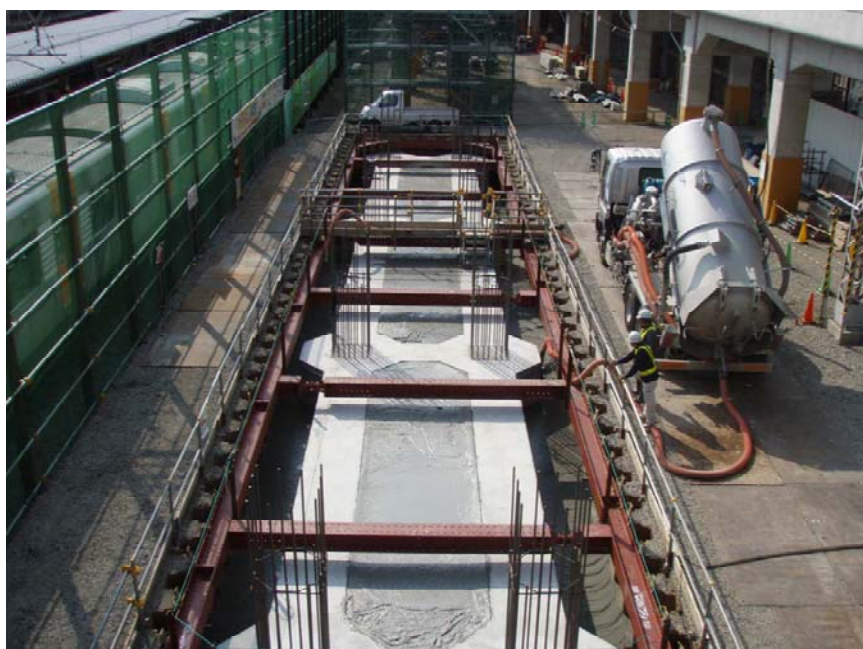
写真. 流動化処理土搬入状況
