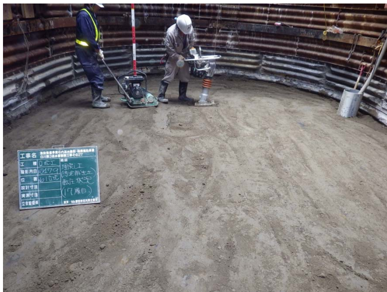
写真. 転圧状況
