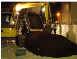
写真. 仮置き場
