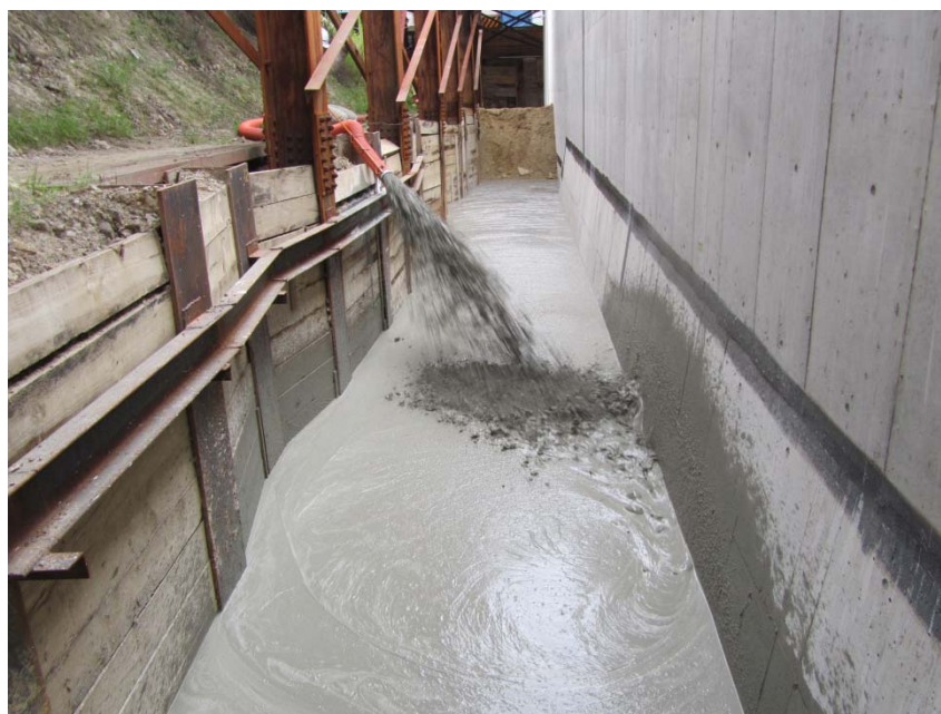
写真. 流動化処理土搬入状況
