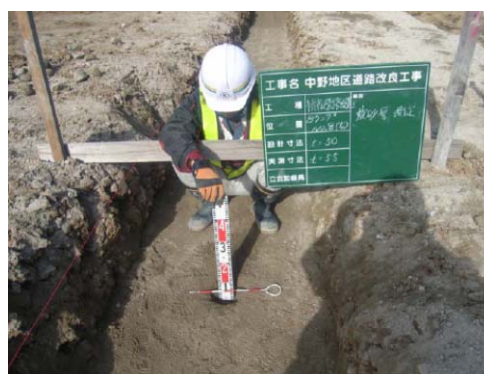
写真. 敷砂厚確認状況
