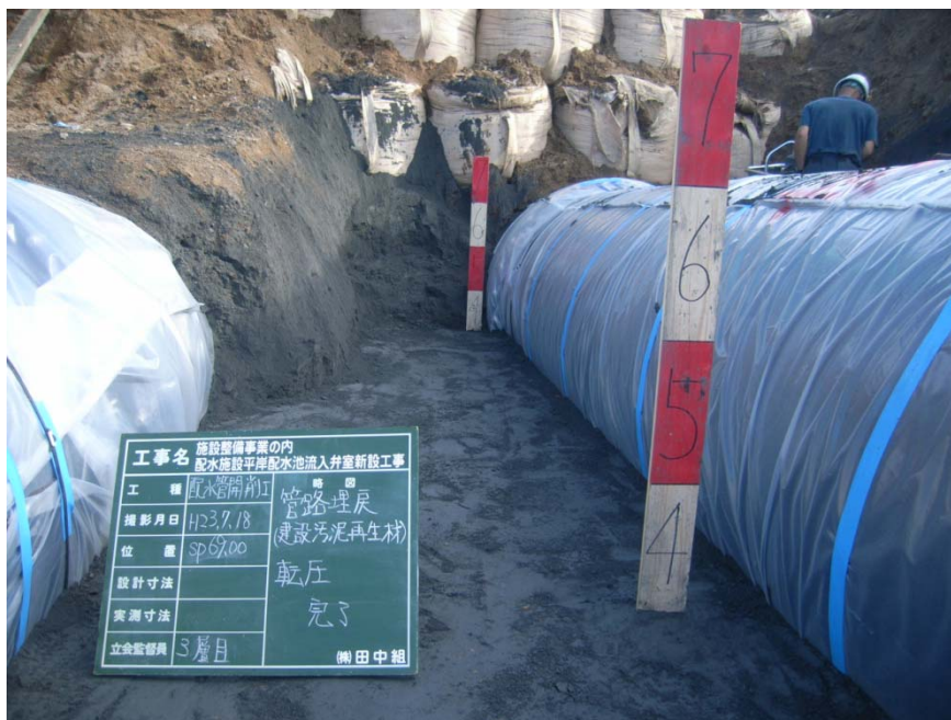
写真. 転圧完了
