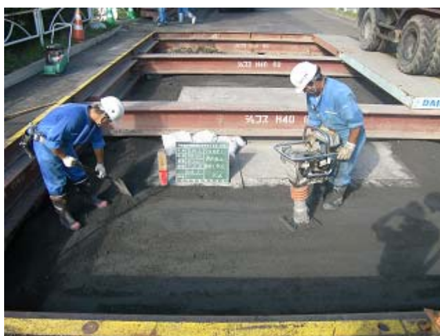
写真. 建設汚泥処理土埋戻し状況
