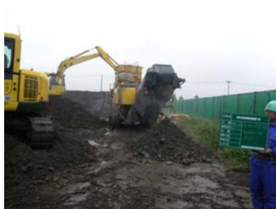
土砂・改良材混合
