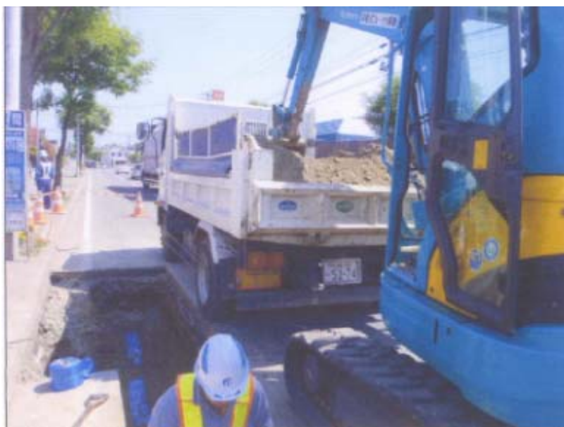
写真. 建設汚泥処理土搬入状況
