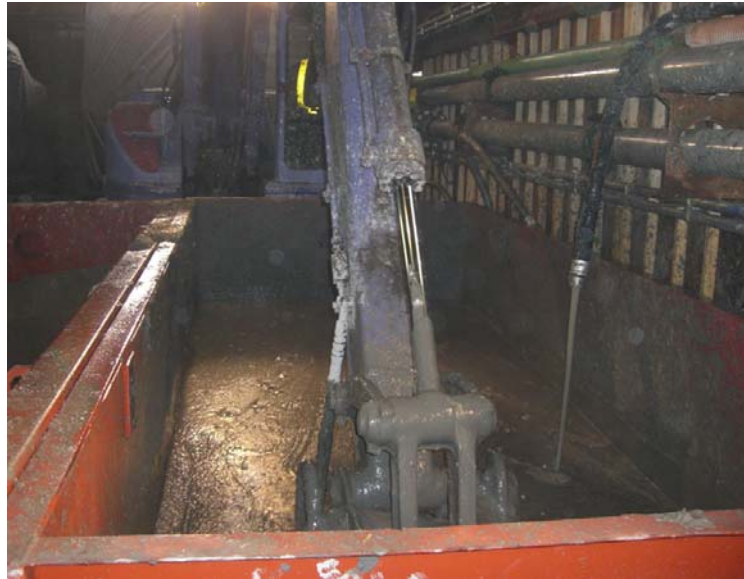
写真. 流動化処理土製造状況
