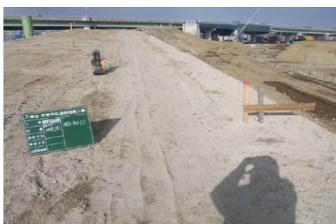
写真. 埋め戻し完了
