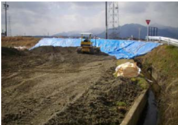
写真. 改良土の敷き均し
