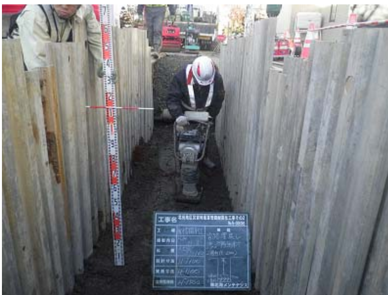
写真. 転圧状況
