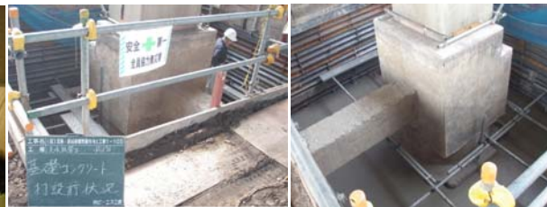
写真. 基礎コン打設状況
