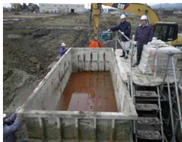
水槽設置確認
