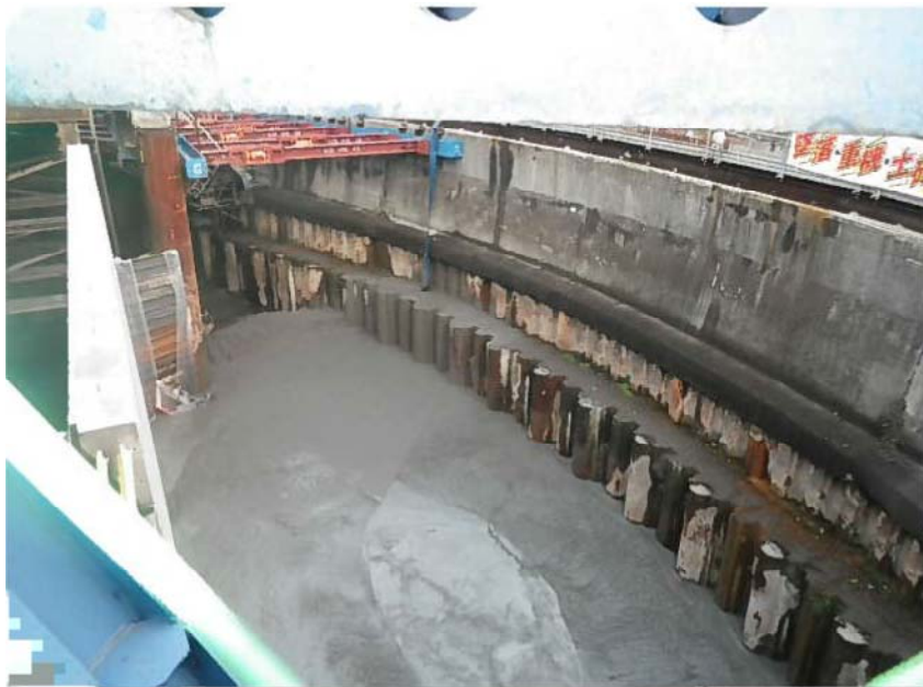
写真. 打設状況
