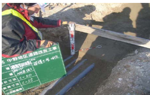
写真. 保護土厚確認状況
