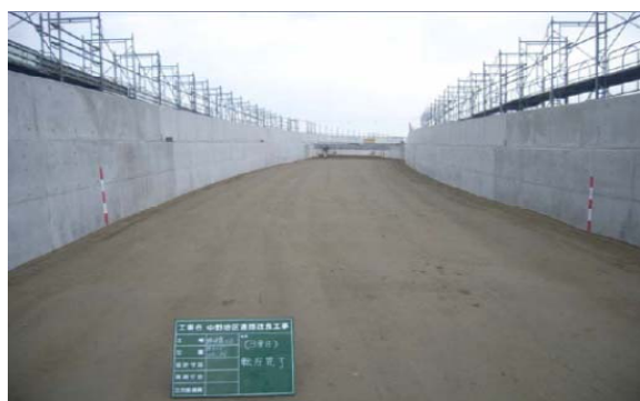
写真. 路床転圧完了
