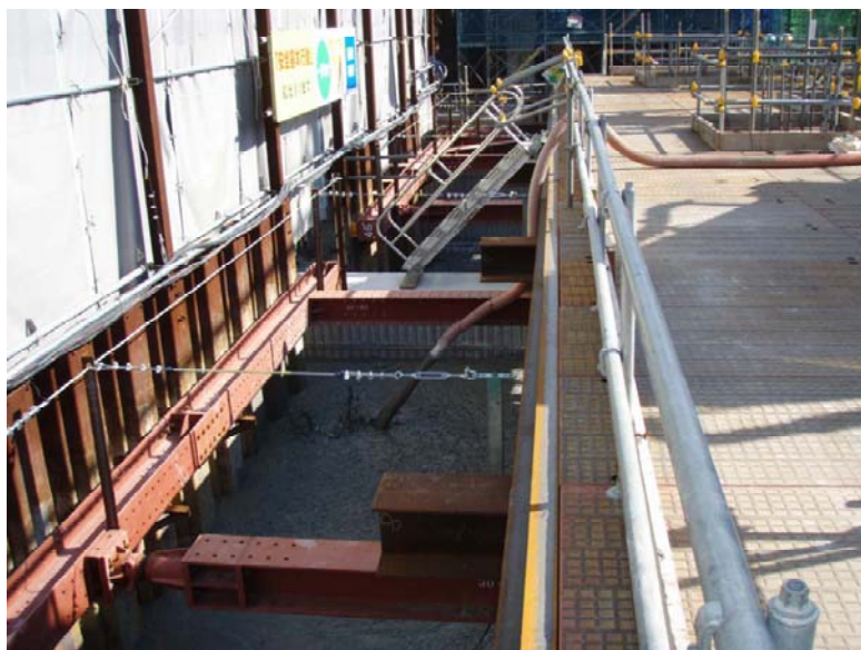
写真. 流動化処理土搬入状況
