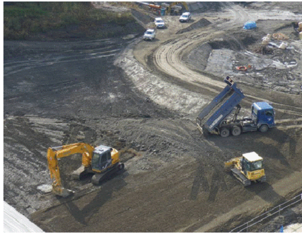
写真. 改質材敷均し状況
