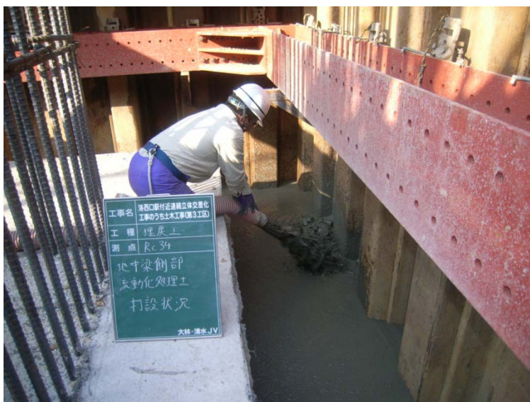
写真. 流動化処理土搬入
