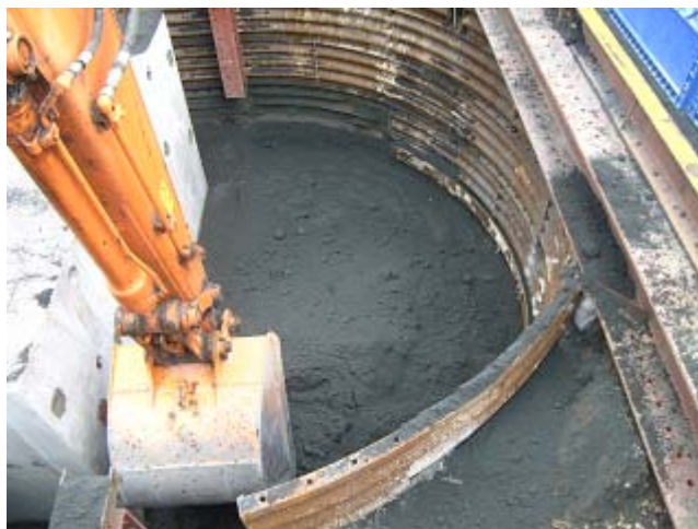
写真. 建設汚泥処理土機械搬入状況
