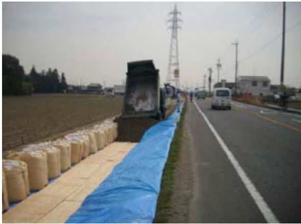
写真. 仮設道路設置のため、改良土搬入
