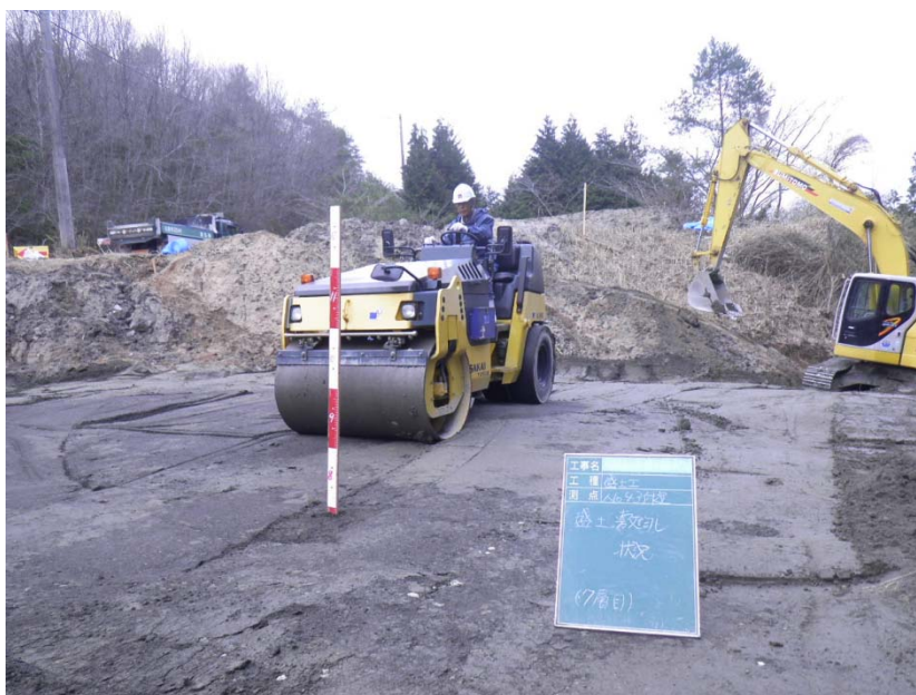
写真. 敷均し状況
