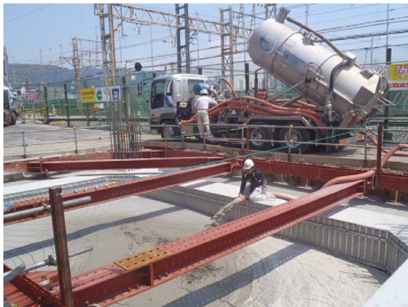
写真. 流動化処理土搬入状況
