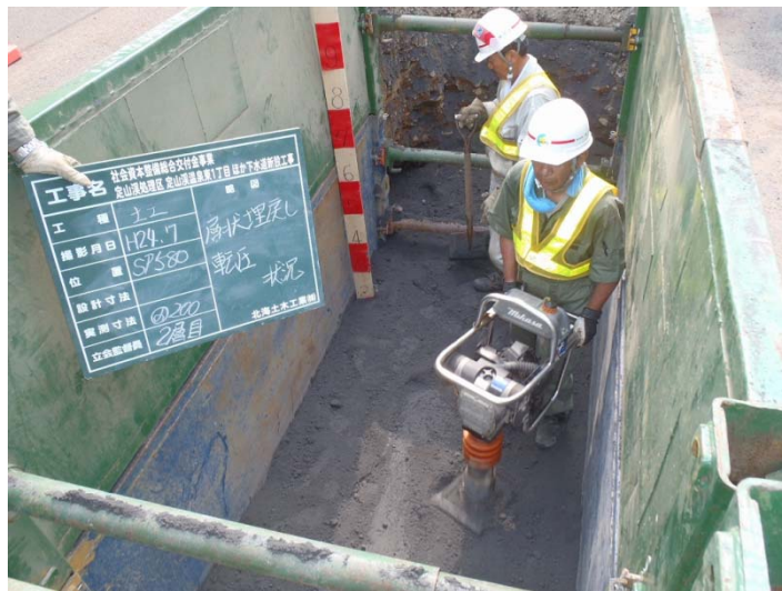
写真. 転圧状況
