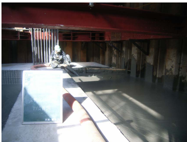
写真. 流動化処理土搬入
