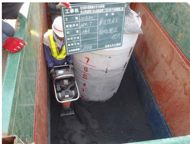
写真. 転圧状況
