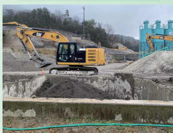
建設汚泥貯留槽
