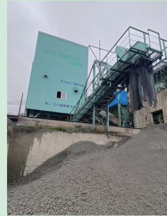
再生球状骨材 (EB) 製造状況
