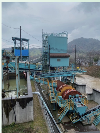
建設発生土再資源化施設
