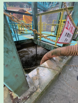
建設発生土を水洗いした余剰水（汚泥）。
