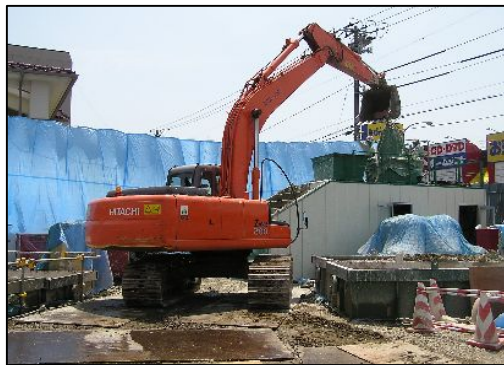
泥土処理状況
