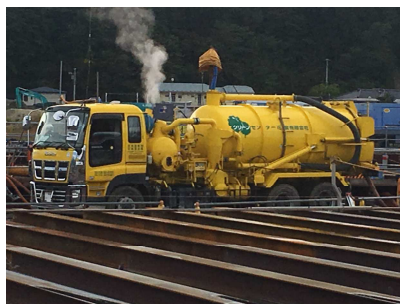
バキューム車による泥土運搬
