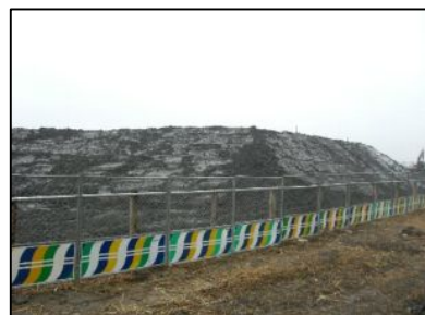
改良土仮置き状況
