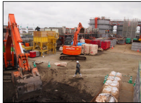
施工ヤード全景
