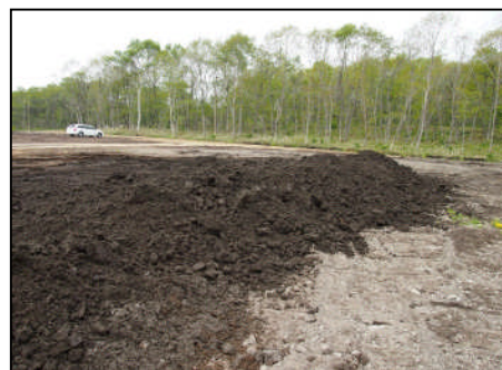
改良土仮置き状況
