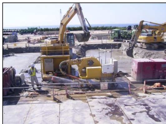
調泥後投入状況
