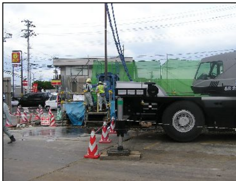
地盤改良工事施工状況
