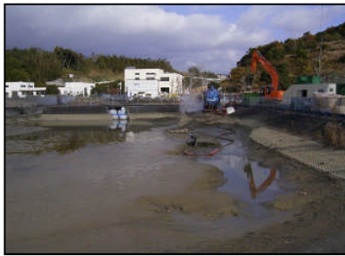
調整池堆積土砂浚渫状況
