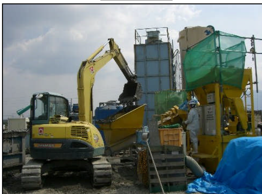
調泥後投入状況
