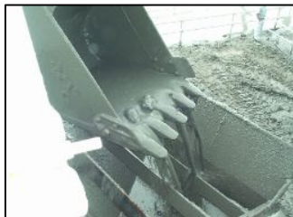
調泥後投入状況
