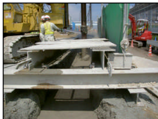
連続地中壁施工状況
