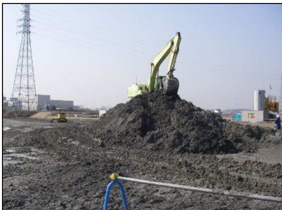
処理土敷均し状況
