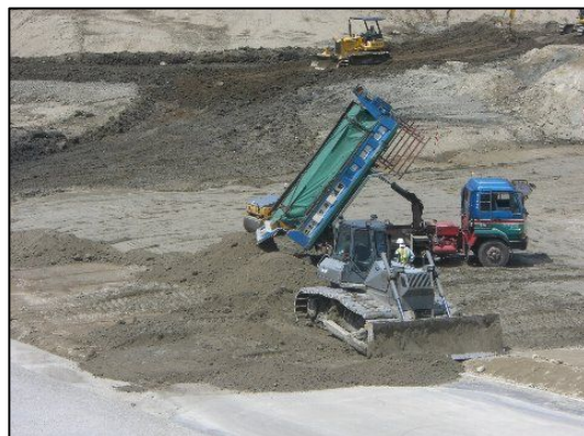
処理土運搬・敷き均し状況
