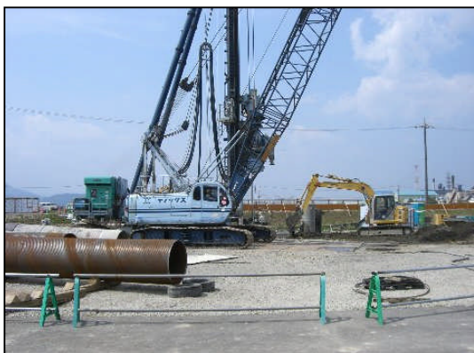
鋼管ソイルセメント 杭施工状況
