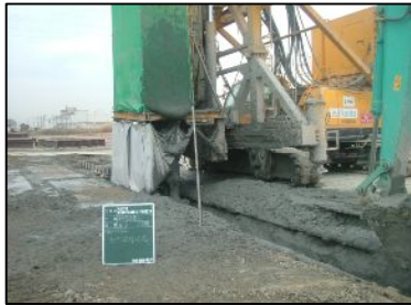
連続地中壁施工状況
