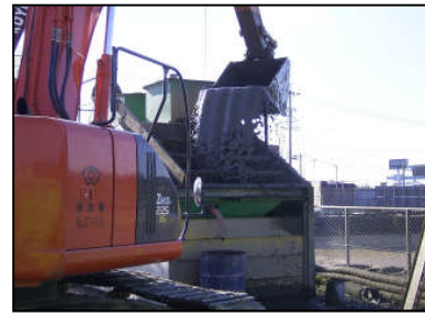
一次処理後泥土投入状況
