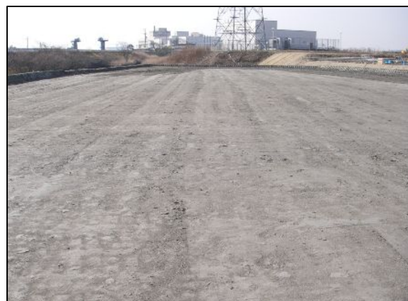
盛土転圧完了
