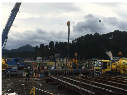
地盤改良工事
