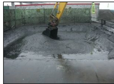
浚渫土砂調泥状況
