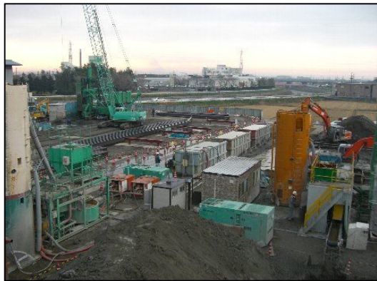
連続地中壁施工状況
