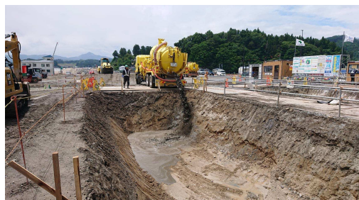
排泥-貯泥調泥処理状況
