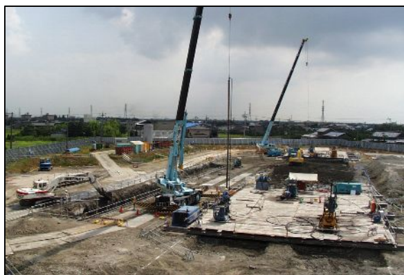
地盤改良 (SJ-M) 施工状況
