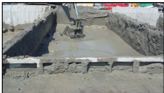
排泥-貯泥調泥処理状況
