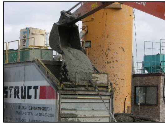
調泥後投入状況
